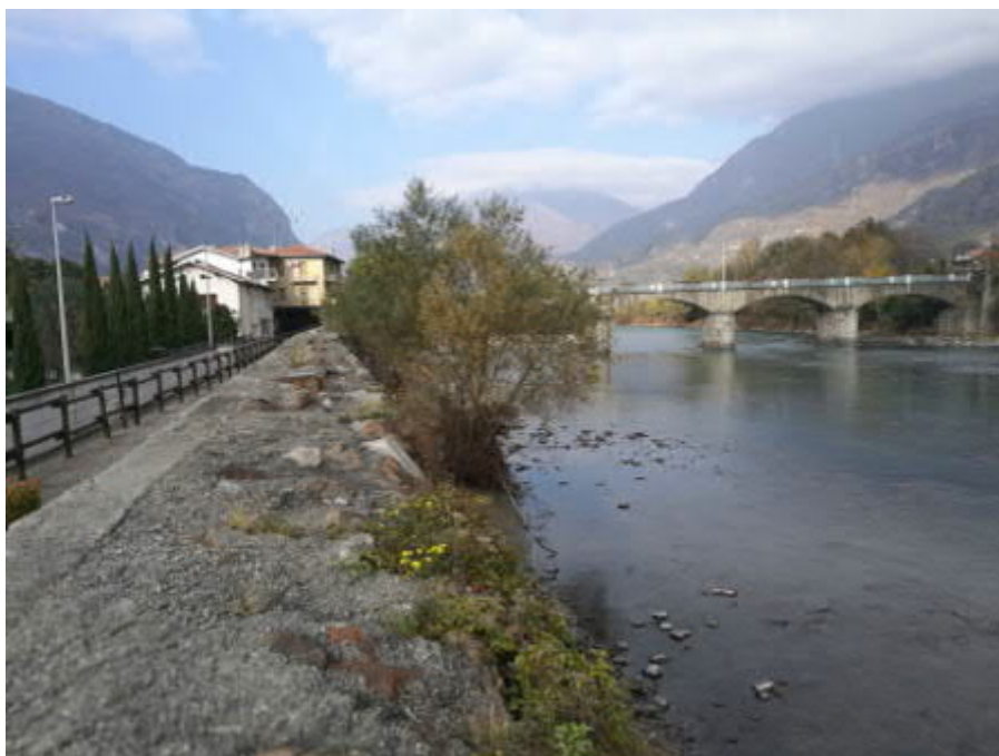
Foto 1: vista del corpo A
